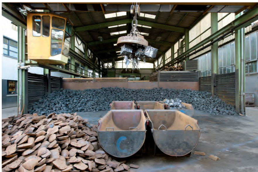
Bild 1: Schadlos überstehen RFID-Transponder an den Chargierbehältern den rauen Umgang beim Beladen in der sog. Gattierhalle der Giesserei
