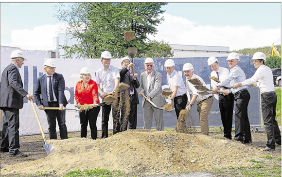
SPÄTENSTICH FÜR DIE NEUE HALLE: Wilhelm Kastner, Karl Röckinger, Katja Mast, Felix Casper, Gunther Krichbaum, Till Casper, Malte Lökig, Peter Schaller, Luca Wilhelm Prayon, Siegmund Rößler und Rouven Thiemermann (von links) legen ihr Bestes. Foto: Faulhaber
